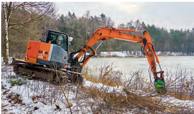
Am Kiesekampsee war ein größerer Bagger von Nöten. Die Firma Wilker hat sich insbesondere der direkten Uferbereiche angenommen. Udo Küpker von der Bramscher NWA-Gruppe hat hier und da mit der Kettensäge nachgeholfen, wo der Kneifer des Baggers nicht richtig arbeiten konnte.
