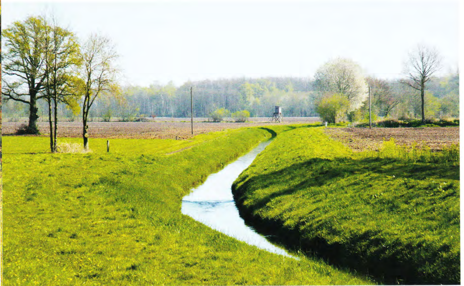
Ahe: Flussaufwärts Straßenbrücke Schaler Straße in der Ortschaft Setlage.
