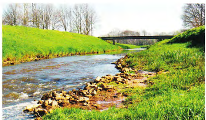
Große Aa: Brücke Geringhusener Damm (etwa Mitte Erlaubnisstrecke).
