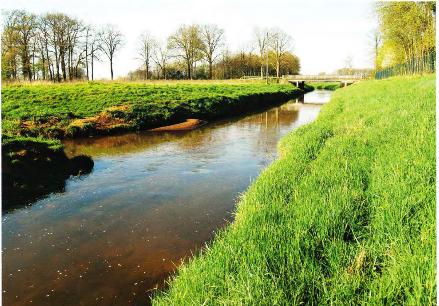
Deeper Aa: Erlaubnisende Deeper Aa (hinten an der Brücke), kurz vorher Einmündung der Schaler Aa.
