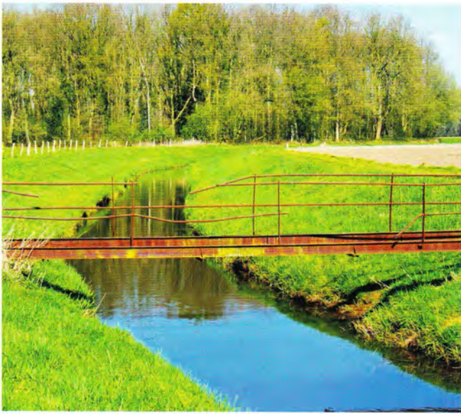
Ahe: Unmittelbar flussaufwärts an der Brücke Schaler Straße.
