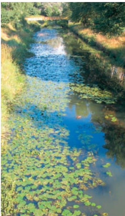
Im Sommer leider total verkrautet: Die Hase in Osnabrück-Haste (Brückenstraße).
