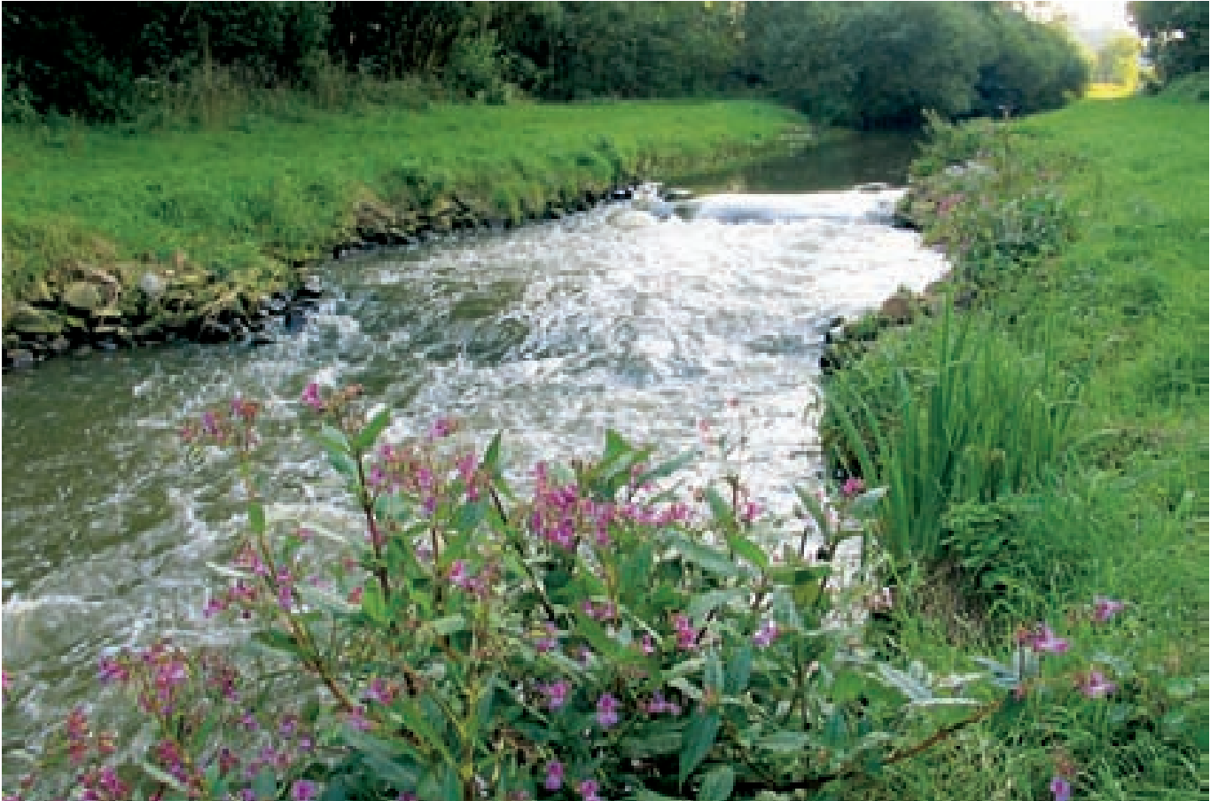
Tiefe Hase parallel zur Malgartener Allee zwischen Sögeln und Bramsche-Malgarten. Hier befand sich noch vor drei Jahren ein Sohlabsturz von mehr als einem Meter Höhe, der zur „sanften“ Sohlgleite umgebaut wurde und nunmehr einen Aufstieg der Wasserlebewesen gewährleistet.
