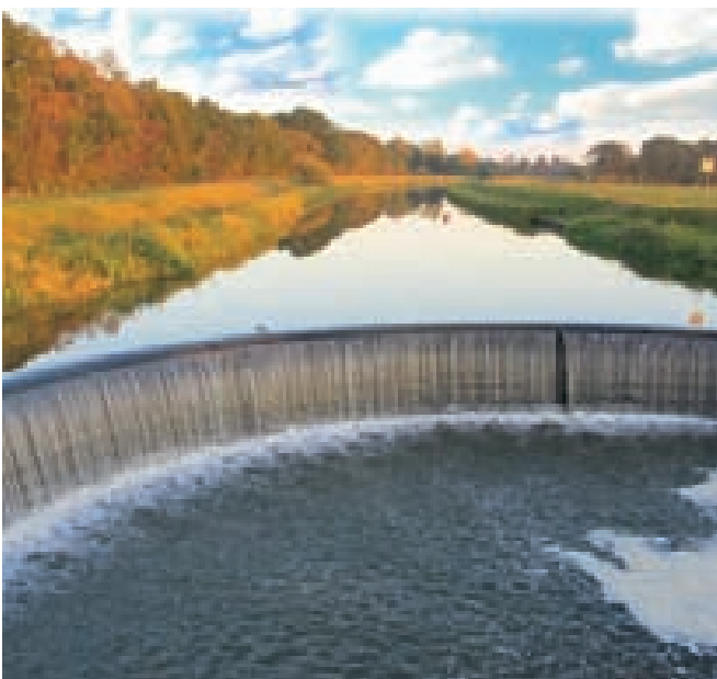
Ein unüberwindbares Gebilde im weiteren Verlauf des Zuleiters: Die Überlaufschwelle an der Hohe-Haar-Brücke.
