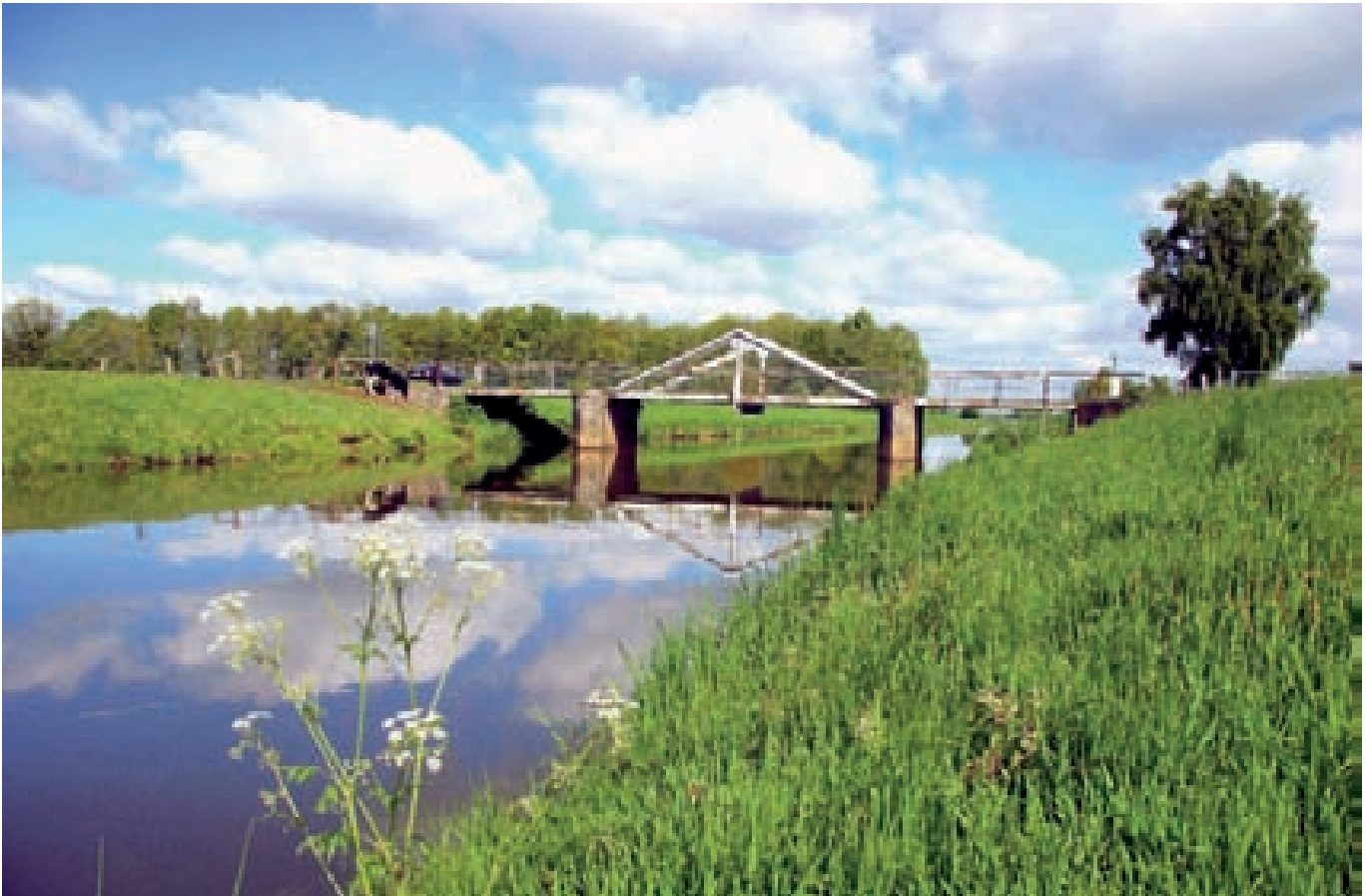
Erlaubnisende Hase II an Narbers Brücke zwischen Badbergen und Quakenbrück.
