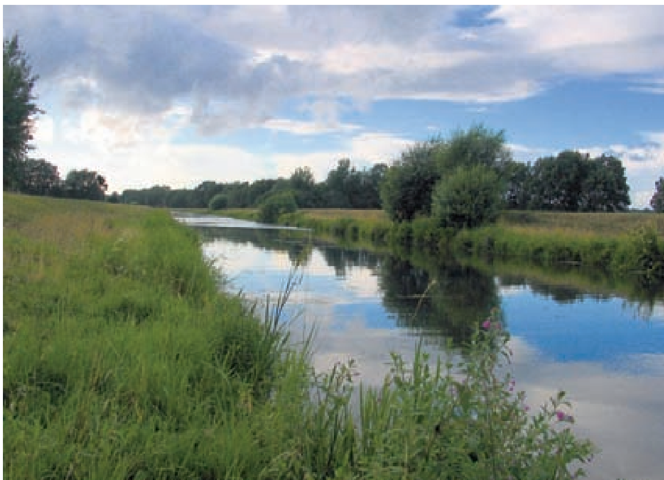
Der Alfsee-Zuleiter als Teil der Fischereigenossenschaft Hase II in Sögel an der Straßenbrücke Riester Damm; etwa einen Kilometer flussabwärts Verteilerbauwerk.
